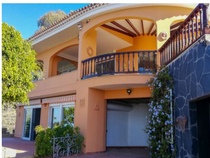
Vista exterior del chalet
