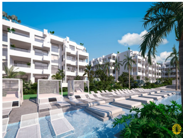
Piscina y fachada
