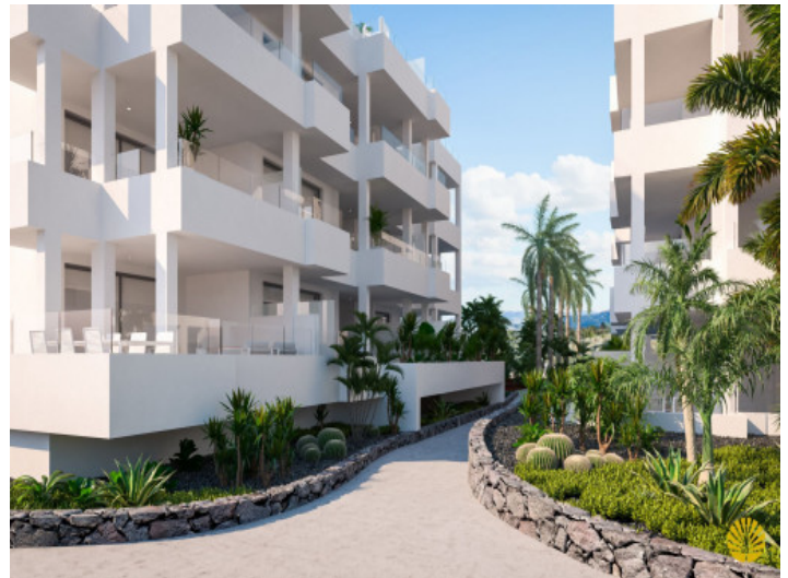
Entrada al edificio
